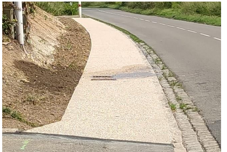
Chemin piétonnier rue d'Avesnes-le-Sec APRÈS
