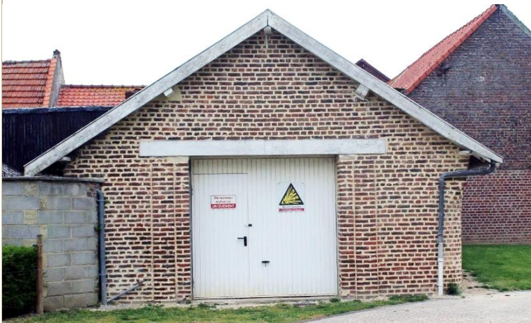
Local carburant rejointoyé
