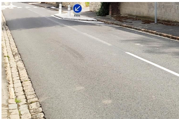
Enrobés (rue d'Avesnes-le-Sec)
