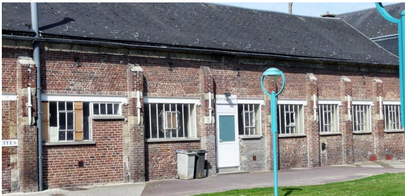
Salle de réception APRÈS travaux
