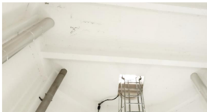
Intérieur du château d'eau APRÈS (échelle et conduites)
