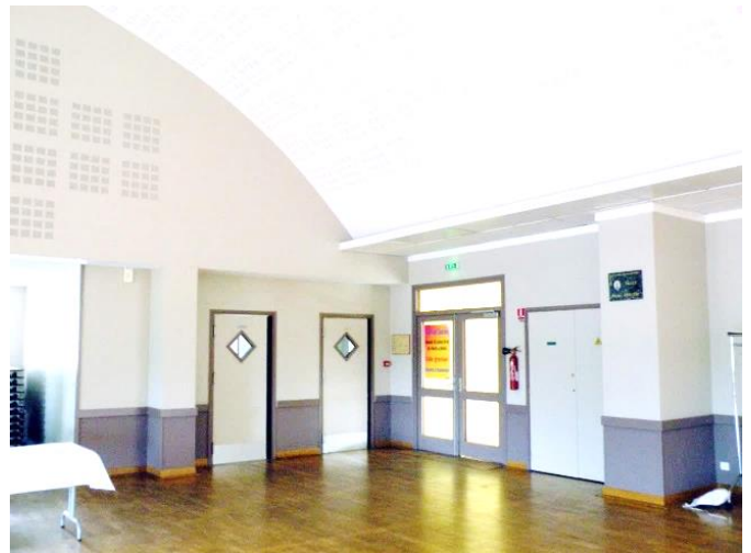
Salle des fêtes remise en peinture
