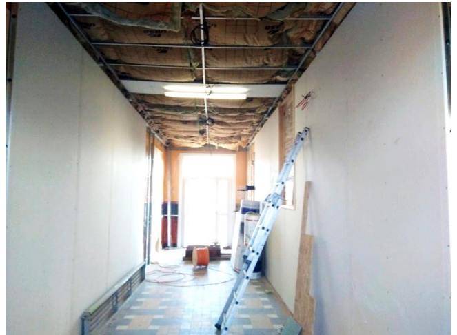
Couloir principal en cours de rénovation (début février)
