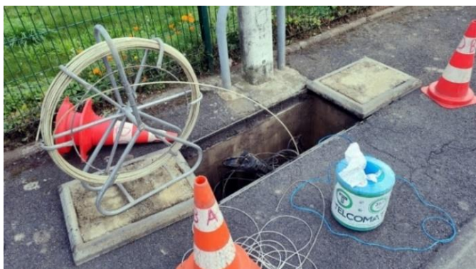
Passage de la fibre optique (rue Demoulin-Moreau)
