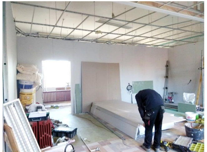
Classe des Maternelles en cours de rénovation (Février)
