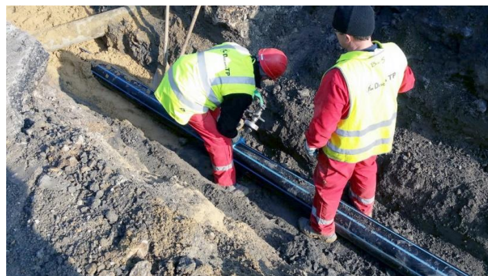
Remplacement de la conduite d'eau et des branchements
