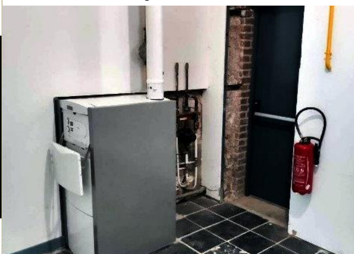
Rénovation du chauffage central
