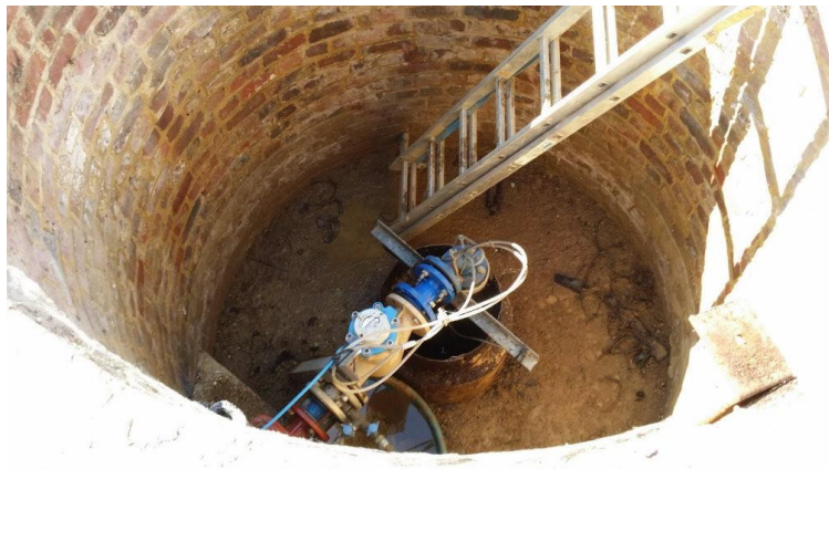
Pose d'une 2 ème pompe au captage
