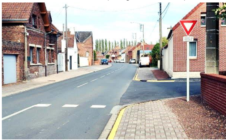
Matérialisation de « Cédez-le-passage » (rue de Haspres)
