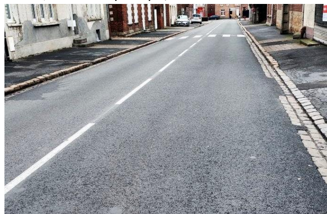
Enrobés (rue de la République)
