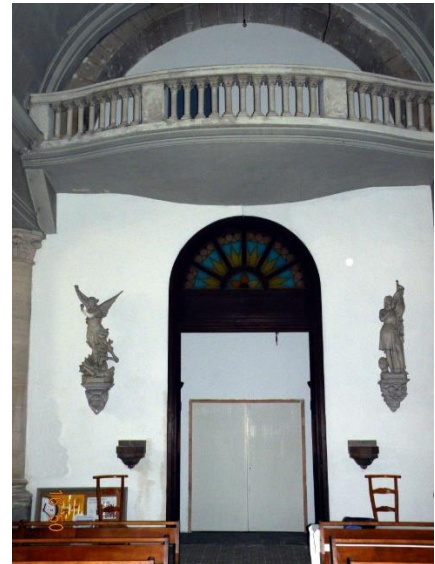
Remise en peinture des murs de la nef
