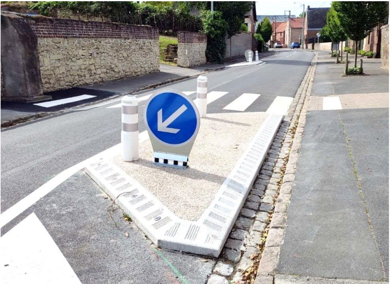
Écluse double rue d'Avesnes-le-sec
