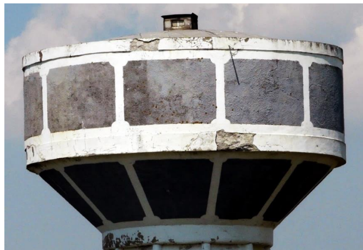
Château d'eau AVANT rénovation
