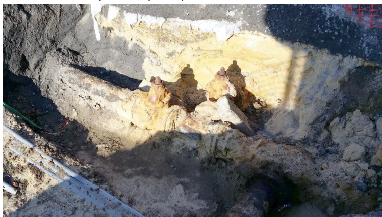
Pose d'une 2 ème pompe au captage
