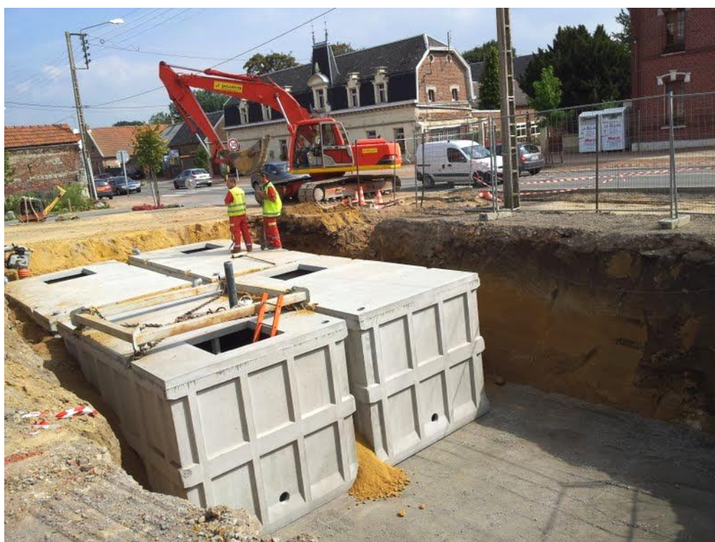
Figure 5: construction de la réserve incendie
