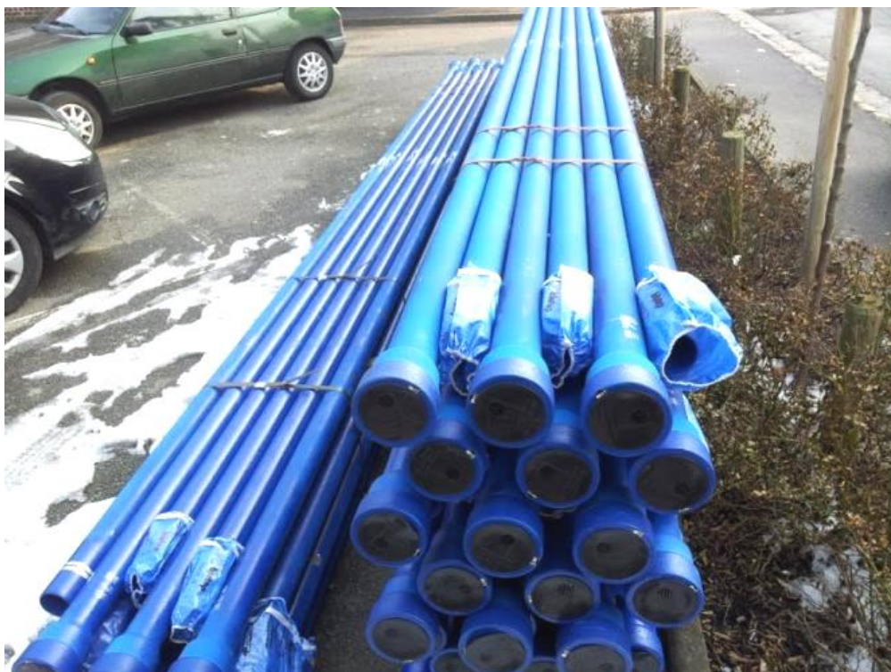
Figure 6: remplacement des conduites d'eau potable rues Zola et Gambetta
