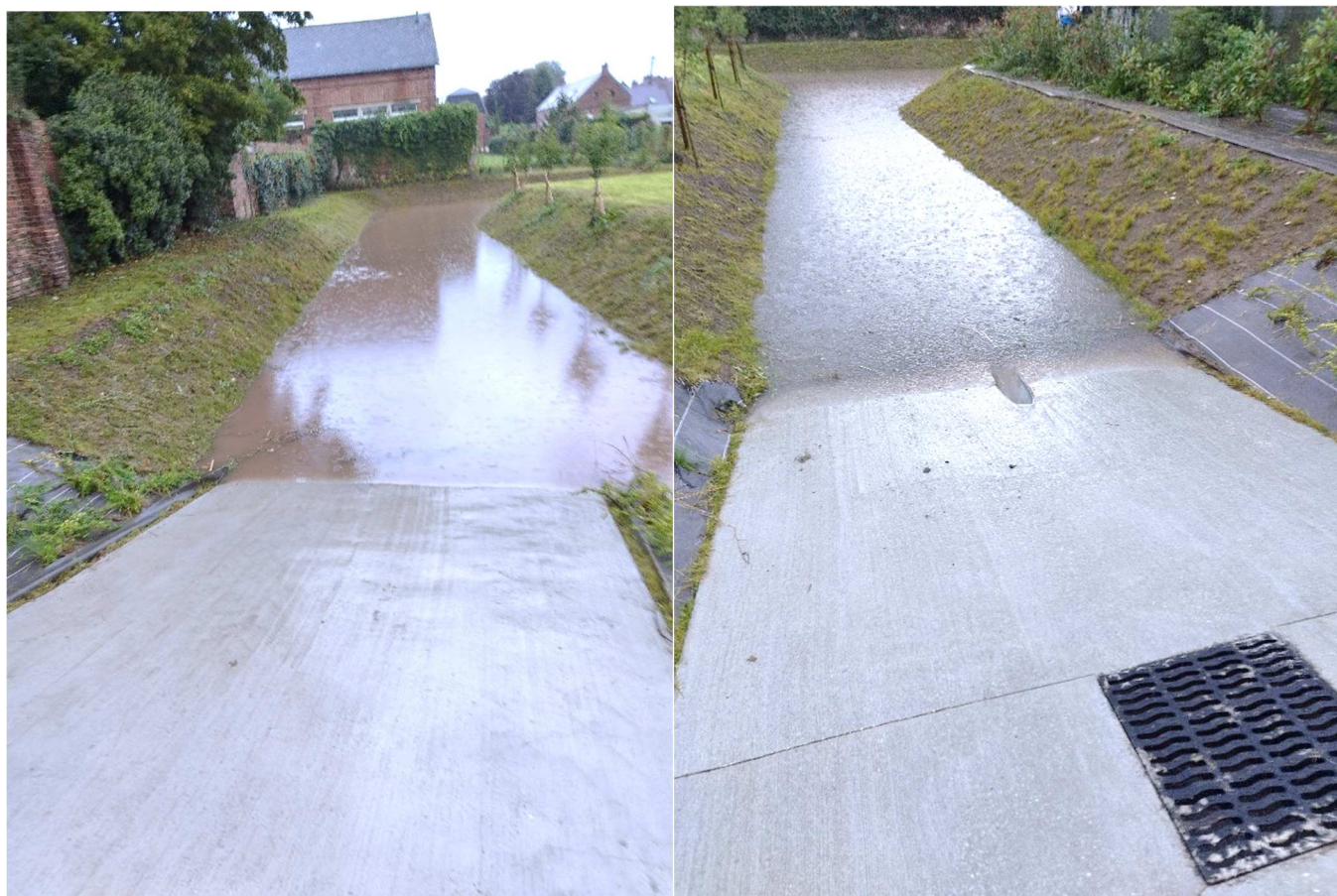
Photos de la noue prises le jour de l'orage (côté rue de Saulzoir et côté rue Jules Guesde)
