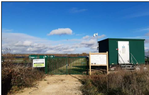
Exemple de panneau pédagogique à l'entrée du parc solaire du Vieux Domaine (Vierzon)
